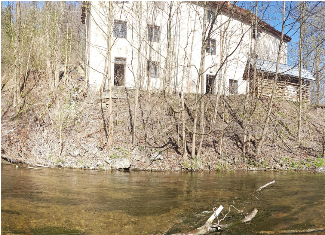
Fot. 4. Widok z brzegu prawego na przedmiotowy budynek i fragment muru. Zdjęcie wykonane podczas inwentaryzacji WTU w kwietniu 2020.
