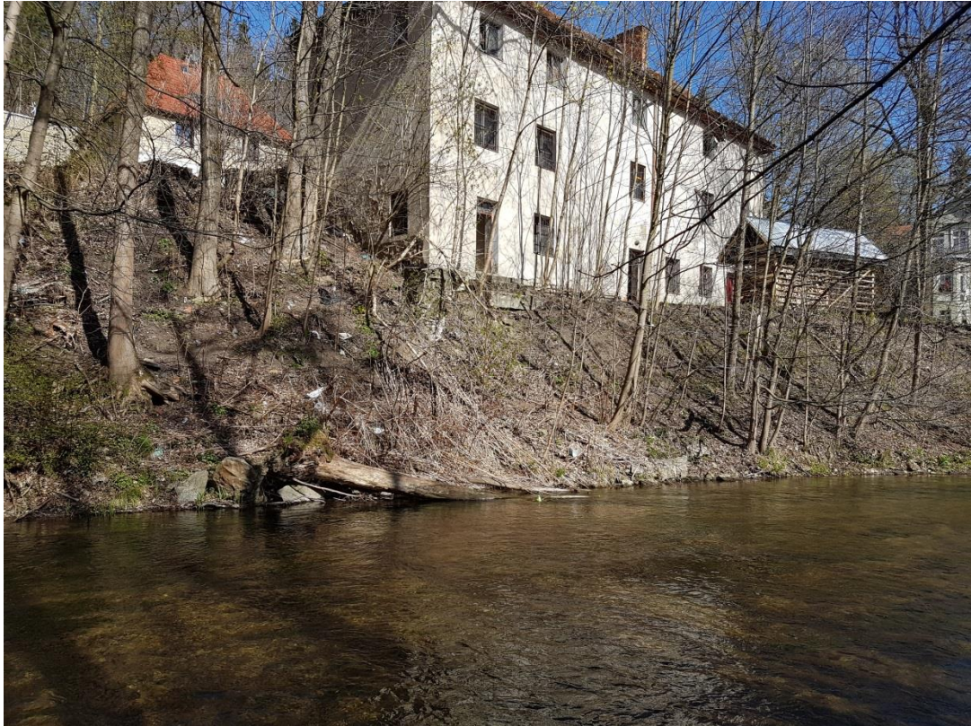
Fot. 3. Widok z brzegu prawego na przedmiotowy budynek i fragment muru. Zdjęcie wykonane podczas inwentaryzacji WTU w kwietniu 2020.
